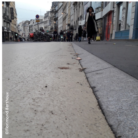
Séparation chanfreinée entre la piste et le trottoir.
